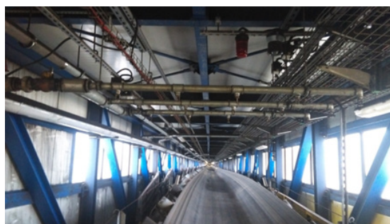
Rys. 21. Instalacja zraszająca przeciwpożarowa Fig. 21. Fire sprinkler system
