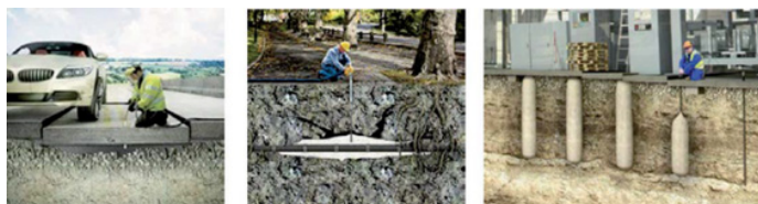
Rys. 10. Przykładowe zastosowanie geopolimerów: a) poziomowanie b) wypełnianie kawern c) wsparcie strukturalne
