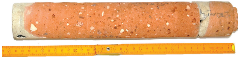
Rys. 5. Widok rdzenia pobranego z obmurza szybu ok. 10 m poniżej zrębu Fig. 5. Core taken from the shaft lining about 10 m below the shaft outset
