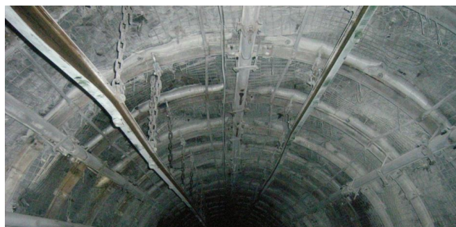
Fot.1 Widok chodnika z wykładką mechaniczną w części stropowej
