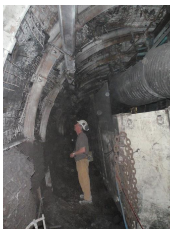
Fot. 3. Widok chodnika na wysokości wysypu czołowego ze ściany
