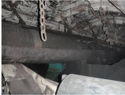
Fot. 5. Widok chodnika na wysokości wlotu do ściany
