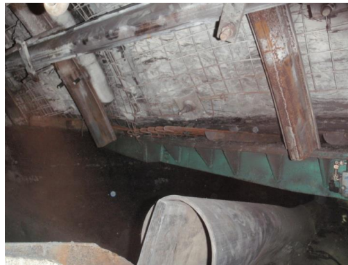
Fot. 6. Widok wlotu do ściany z wypiętymi łukami ociosowymi obudowy ŁPSC
