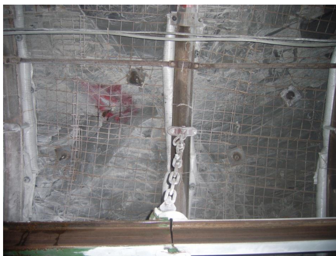
Fot. 2. Widok chodnika z wykładką mechaniczną i kotwami prętowymi w części stropowej
