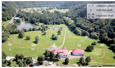
Fig. 2. A drone image of the area of interest with marked main constructions Rys. 2. Widok z drona na badany obszar z zaznaczonymi głównymi konstrukcjami
