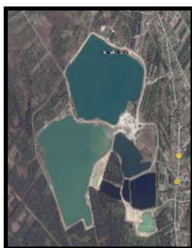
Fig. 2. Zespół zbiorników poeksploacyjnych [www.geoportal] Fig. 2. System of post-mining tanks [www.geoportal]
