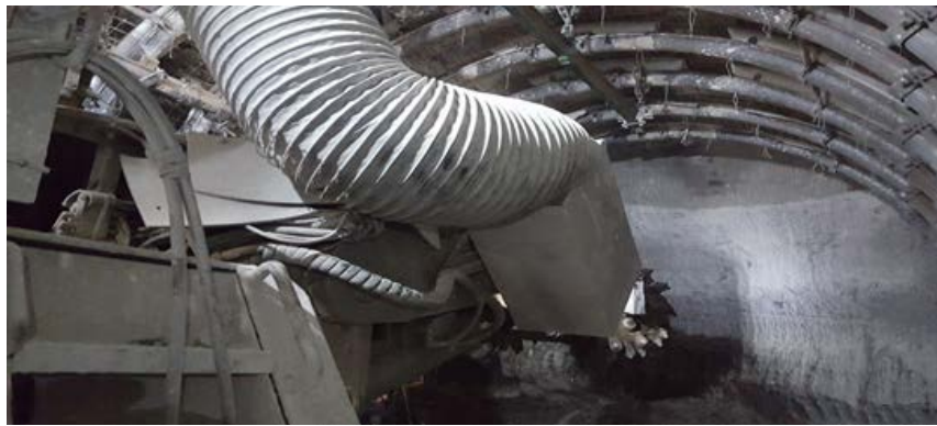
Rys. 7. Widok przodka z stanowiska kombajnisty [1]
