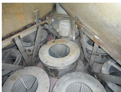
Rys. 20. Filtry w kolumnie filtracyjnej SNK
