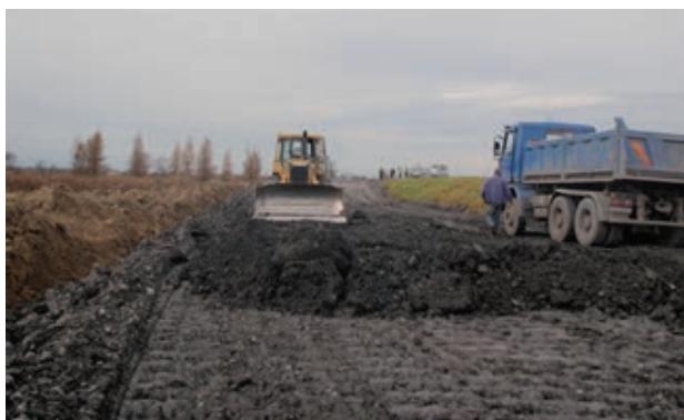
Fot. 6. Budowa wałów przeciwpowodziowych na Wiśle z zastosowaniem kruszywa „osuszonego” popiołem z ZG „Janina”
