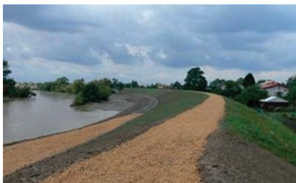
Fot. 6. Budowa wałów przeciwpowodziowych na Wiśle z zastosowaniem kruszywa „osuszonego” popiołem z ZG „Janina”
