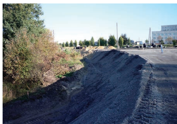
Fot. 5. Budowa obwodnicy Chrzanowa z zastosowaniem mieszanki kruszywo-popiołowej z ZG „Sobieski”
