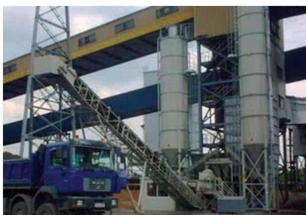
Fot. 4. Instalacja do produkcji mieszanek kruszywo-popiołowych w ZG „Sobieski”
