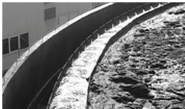
Rys. 2. Stan powierzchni wody z odcieku z wirówek w zagęszczaczu promieniowym [4]
