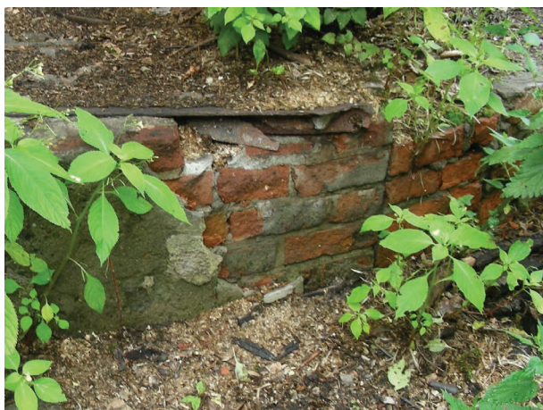
Rys. 8. Widok miejsca lokalizacji szybu „Leśny I”
