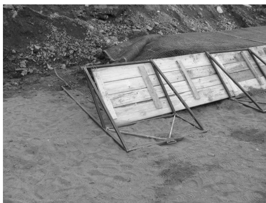
Fig. 3. The lower part of the west Heap slope [3] Rys. 3. Dolna część zachodniego zbocza hałdy [3]
