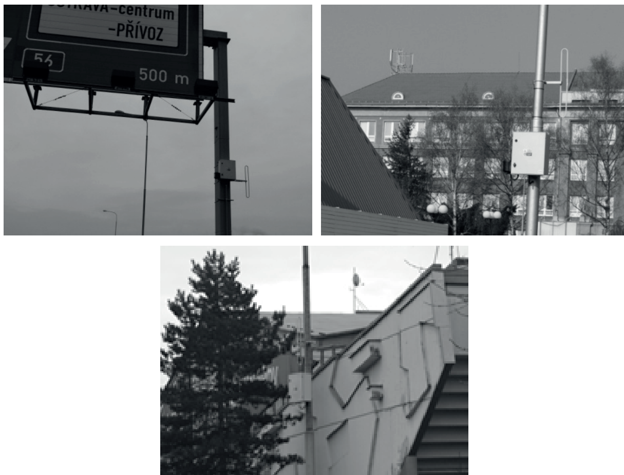
Fig. 5. Position of sensors and data distribution cabinets Rys. 5. Lokalizacja czujników i koncentratorów danych
