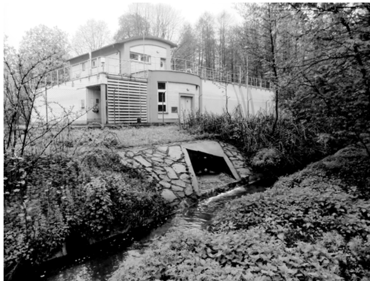
Fig. 4. Sewage treatment plant with an outcome into a small water resource Rys. 4. Oczyszczalnia ścieków dla niskiego zasobu wody
