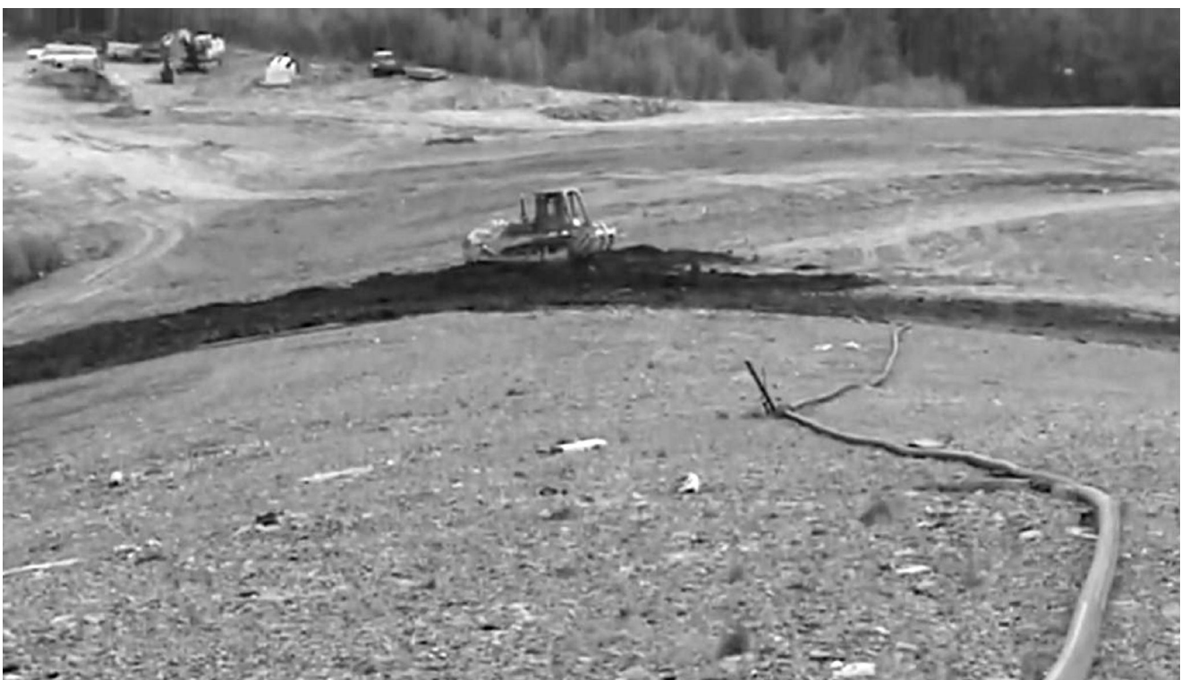
Rys. 4 Maszyny na Hałdzie Centralnej [1]
